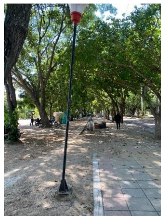
Imagen 3: Luminarias existentes sin funcionamiento
