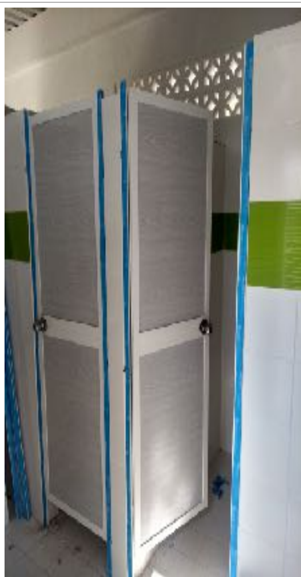
Foto N° 38 Vista General, Zona de Baños, Instalación de Puertas
