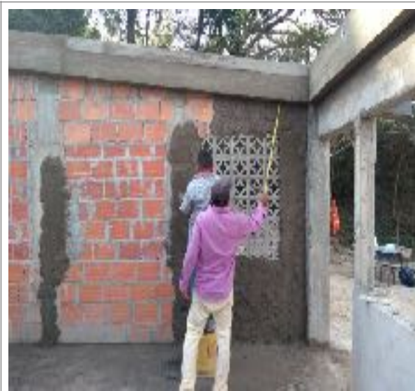
Foto N° 5 Vista General, Pañete sobre muros internos del salón de clases
