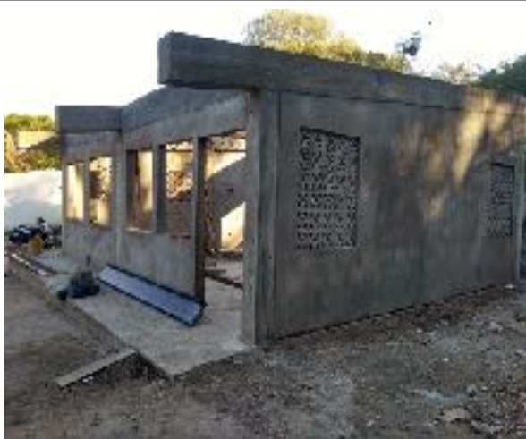
Foto N° 10 Vista General, Pañete sobre fachada Lateral Derecha y Muros Internos del salón de clases
