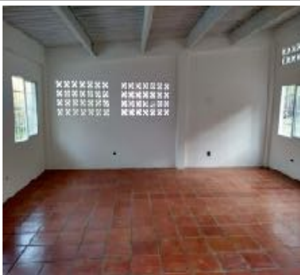
Foto N° 29 Vista General, Piso en Tablón Gres
