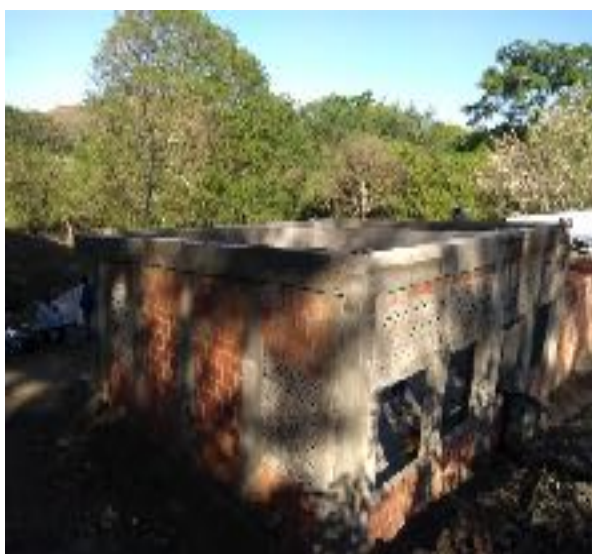
Foto N° 8. Vista General, Altura de Viga Aérea
