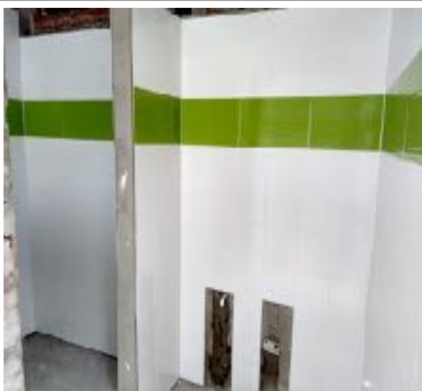
Foto N° 25 Vista General, Instalación Enchape Cerámico para piso y pared 20 x 20 cm, Zona de Baños
