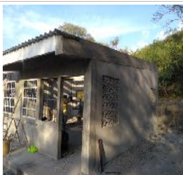
Foto N° 17 Vista General, Instalación de Cubierta de teja arquitectónica galvanizada
