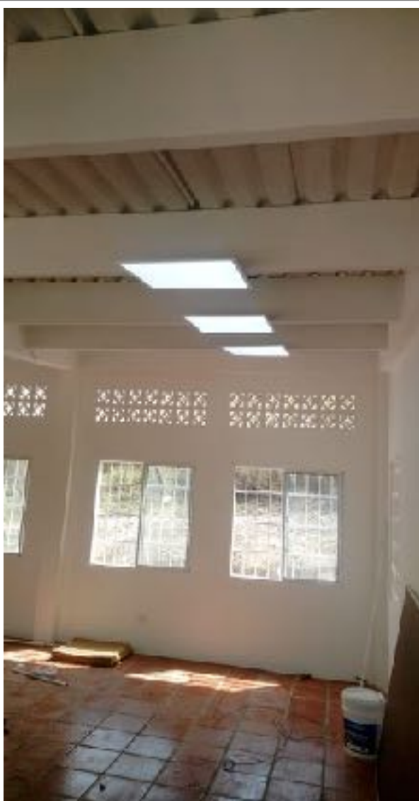
Foto N° 33 Vista General, Instalación panel Led (40w60x60) cm
