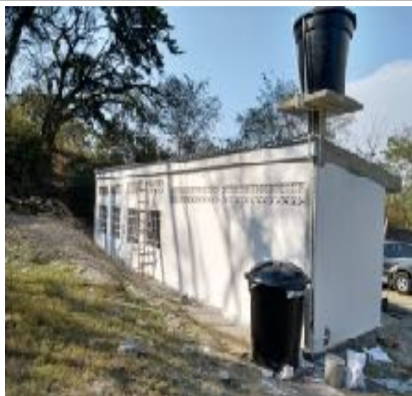
Foto N° 32. Vista General, Facha Lateral Izquierda y Frontal de Zona de Baños
