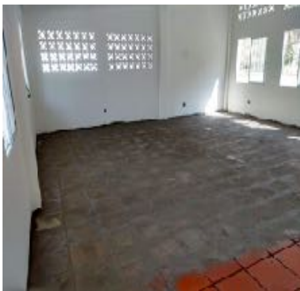
Foto N° 28. Vista General, Detalle de Piso Tablón de gres 33 x33 cm (salon principal)
