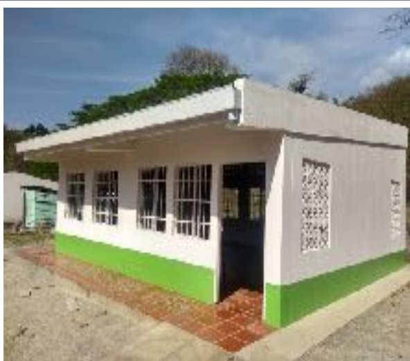
Foto N° 35 Vista General, Vista General, Instalación de canal de aguas lluvias lámina galvanizada cal18, d: .60m
