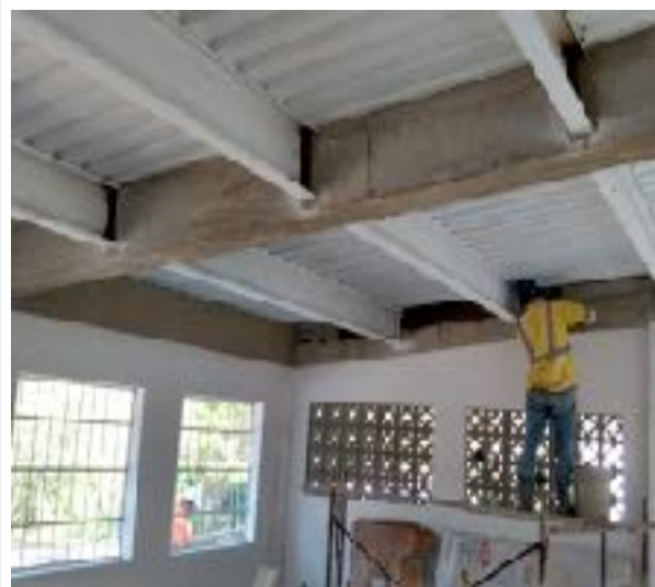
Foto N° 22. Vista General, Detalles de Viga Aérea interna, para acabado final
