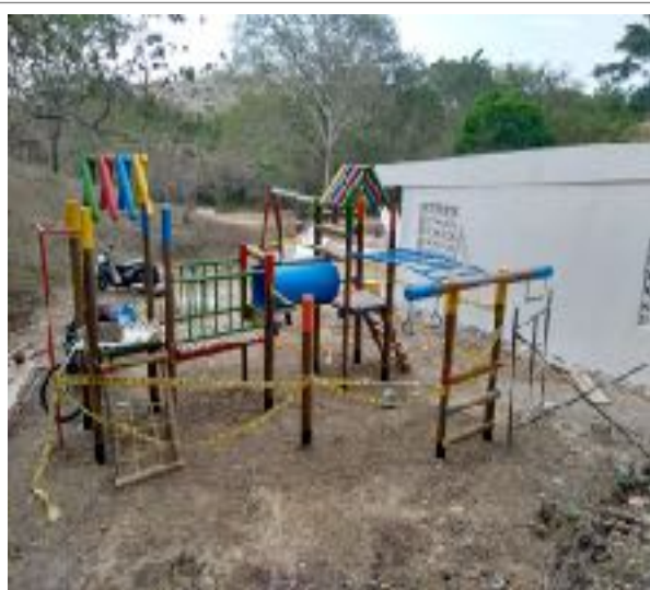
Foto N° 31 Vista General, Instalación Parque Infantil
