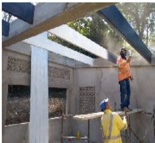
Foto N° 16. Vista General, Pintura Anticorrosiva para Estructura metálica de cubierta
