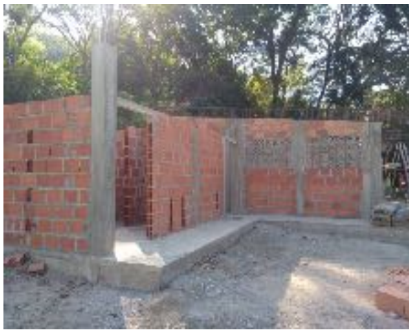
Foto N° 1. Vista General, Levante de Muro en Bloque N°5, hasta altura de viga aérea
