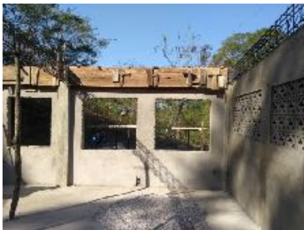
Foto N° 2. Vista Interior del Aula de Clase, Pañete sobre Y Colocación de Formaletas para fundida de Viga Aérea.
