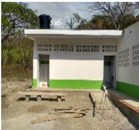
Foto N° 36. Zona de Baños: Instalación de canal de aguas lluvias lámina galvanizada cal18, d: .60m
