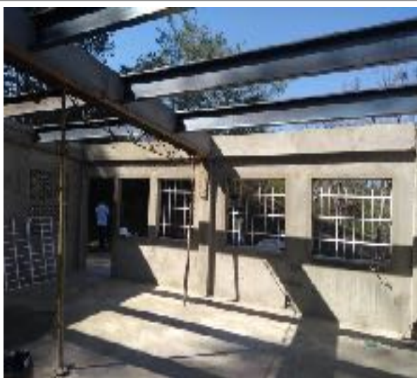
Foto N° 14. Vista General, Colocación de Protectores para Ventanas
