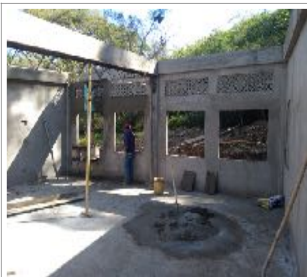
Foto N° 7 Vista General, Detalle de pañete sobre fillos
