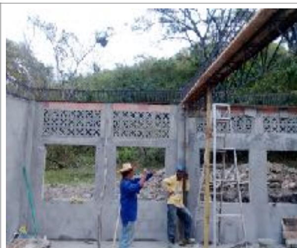
Foto N° 3. Vista General, Colocación de acero de viga aérea
