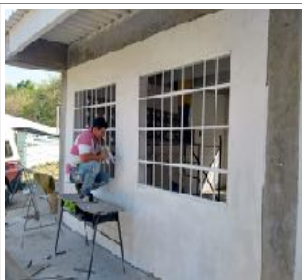
Foto N° 21 Vista General, Acabado de fachada frontal en Estuco y Pintura Tipo 1
