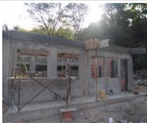
Foto N° 4. Vista General, Pañete sobre muros y fundida de viga aérea
