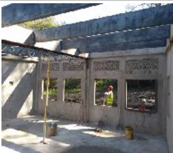
Foto N° 12. Instalación Estructura metálica de cubierta, correas en perfil c 254mm x 67mm, 18mm ( anticorrosivo)
