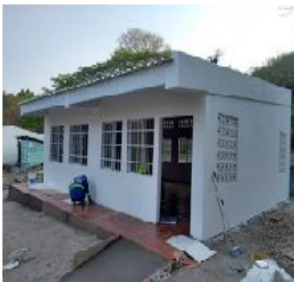
Foto N° 30. Vista General, Acabado final de Facha Frontal del Aula de Clases
